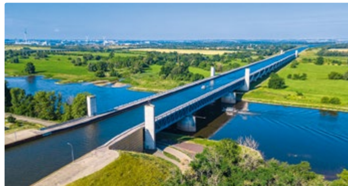
▼ Wasserstraßenkreuz bei Hohenwarthe
